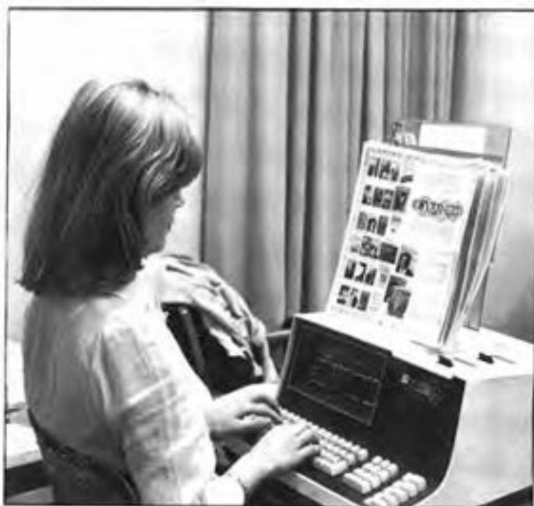
Abb. 4.11 Dieser Konzepthalter sollte hinter dem Tastenfeld aufgestellt werden. Wenn jedoch das Tastenfeld ein fester Bestandteil des VDT-Gehäuses ist, dann steht das Manuskript oft zu hoch. Im dargestellten Beispiel ist dieses Problem kaum gegeben, da der Bildschirm selbst nicht sehr hoch steht – genau genommen steht er zu niedrig, als daß man ihn bequem lesen könnte. Ref. K. 26
