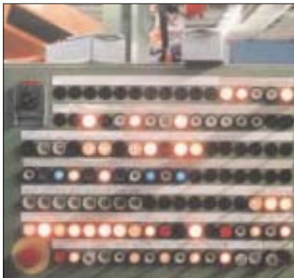
Bild E.21 Falsche Bedeutungszuordnung durch zu hohen Kontrast der unwichtigeren Objekte (weiße Lampen) gegenüber den wichtigeren (Blaue Anzeigen, die beachtet werden müssen.) /E.17/
